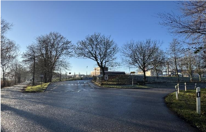
Bild 9: Klärwerk Hetlingen, Am Heuhafen 2 in 25491 Hetlingen
