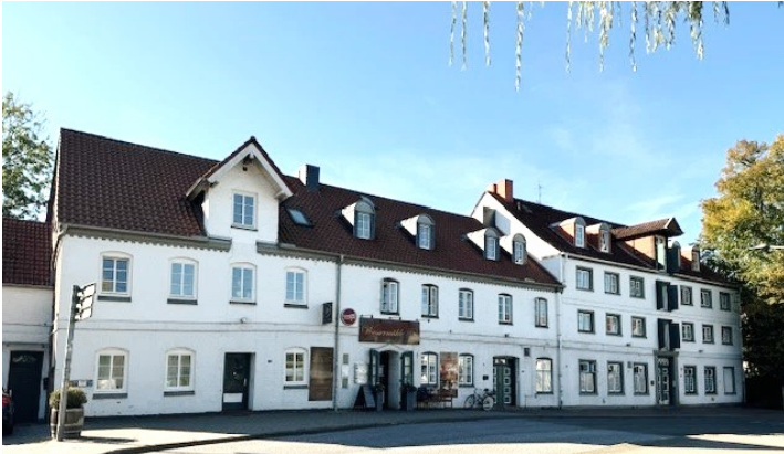
Bild 11: Wassermühle Wedel, Mühlenstraße 30 in 22880 Wedel
